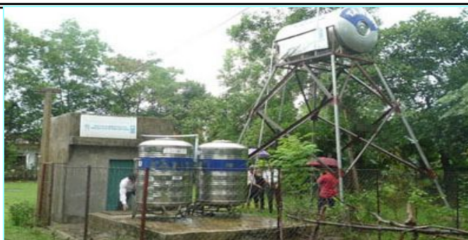
Công trình cấp nước tập trung của xã Kỳ Nam (Kỳ Anh) không còn tác dụng, đang bị bỏ hoang do nguồn nước không sạch, không được quản lý, sửa chữa.
