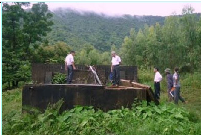
Công trình cấp nước tập trung ở xã Cẩm Mỹ (Cẩm Xuyên) xây dựng xong nằm “đắp chiếu” do không có nguồn nước sử dụng.
